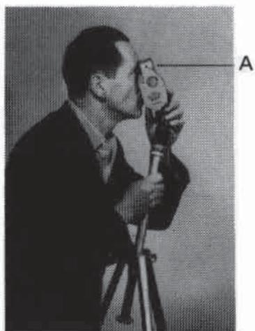
Fig.2 - Il relascopio montato sul treppiede.
